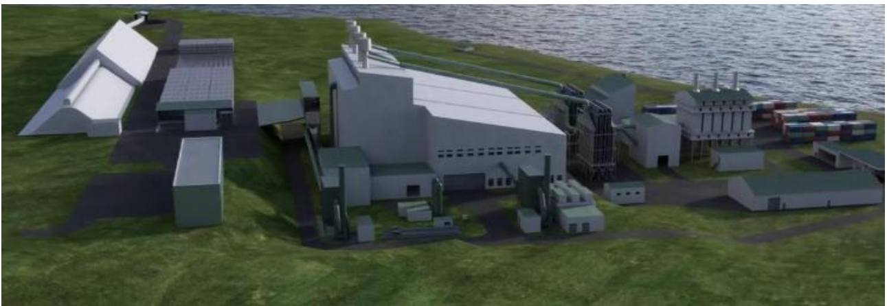
MYND 1 Líkanmynd af kísilmálmverksmiðju PCC BakkiSilicon skv. 1.áfanga. Hreinsivirkið er með þrem reykháfum og er staðsett hægra megin á myndinni (Heimild: www.pcc.eu )
